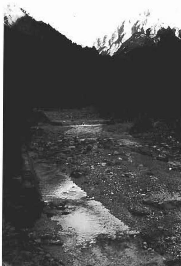
Fig. 3 - Difese contro l'intensa erosione esplicata dal Torrente Dogna (Est-Ovest) sulle formazioni triassiche tettonizzate. Sul fondo il massiccio del M. Montasio (q. 2753 m.s.l.m.).
